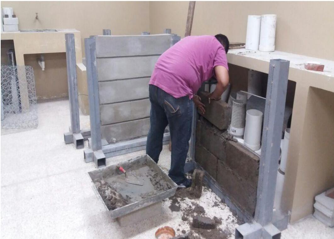
**Anexo 10.** Construcción de paredes en base a bloques con cascara de arroz. Foto tomada por: Castillo Washington y Lindao Rolando
