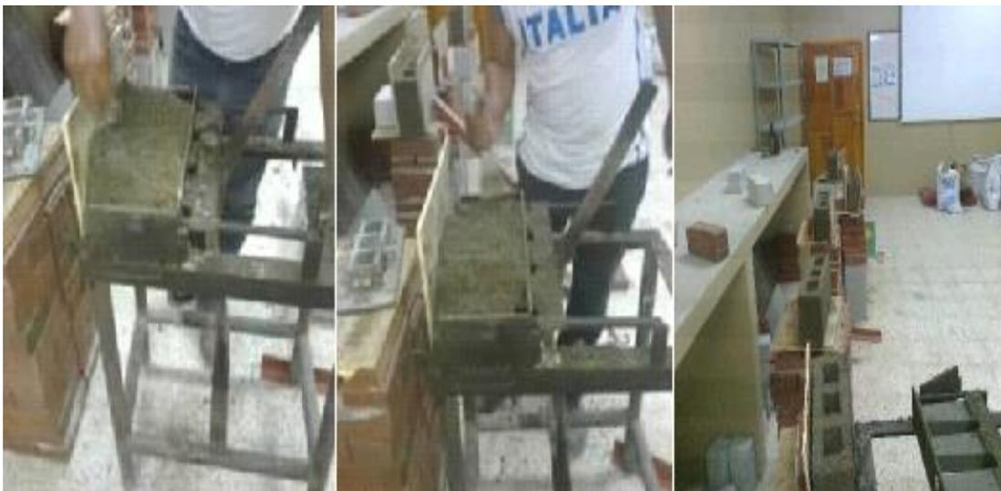
**Figura 25.** Elaboración y secado de los bloques. Foto tomada por: Castillo Washington y Lindao Rolando
