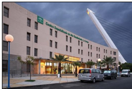
Figura 21: Centro de Alto Rendimiento La Cartuja - Sevilla España
