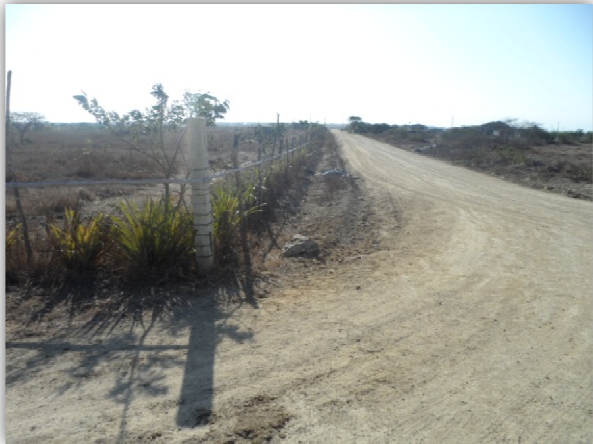
Figura # 63. Vía Secundaria de lastre en San Pablo – Santa Elena – Ecuador.
