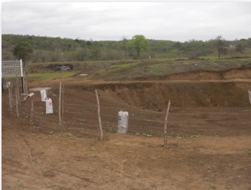
Ilustración 20 Pozos para reservorios de agua
