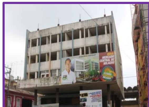
Remodelación del Mercado Central
