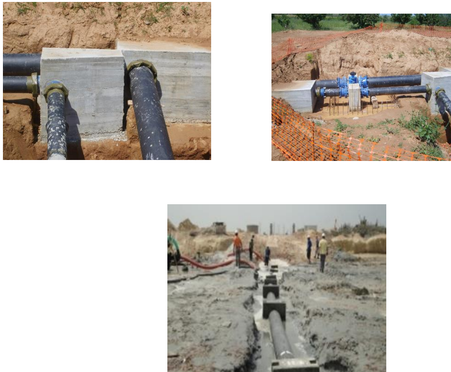
FIGURA 17 Diferente tipo de anclaje (Anclaje de Tubería, 2015)
