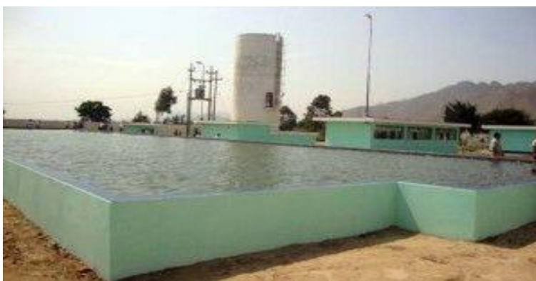
FIGURA 8 Depósito de agua (sistema de agua potable, 2012)
