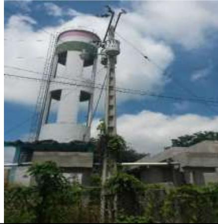
Tanque para la dosificación del hipoclorito con el propósito de eliminar bacterias, gérmenes en el agua.
