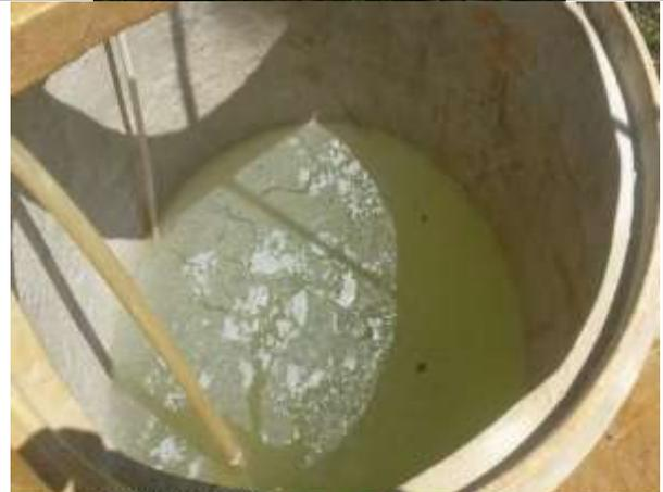
Tanque para la dosificación del hipoclorito con el propósito de eliminar bacterias, gérmenes en el agua y tanque con Policloruro de aluminio.
