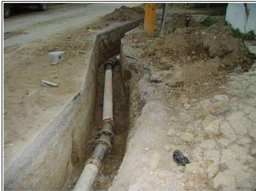
Figura 27: Tubería de Asbesto Cemento
