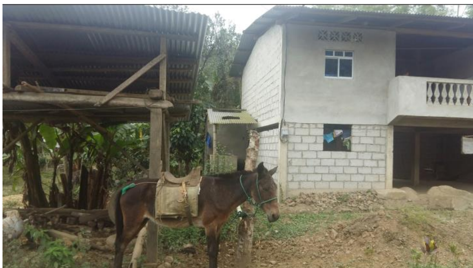
FIGURA # 5: VIVIENDA RURAL DE CEMENTO EN COMUNA CHARQUIYACU AUTOR: ANGÉLICA ALEJANDRA MUÑOZ FRANCO
