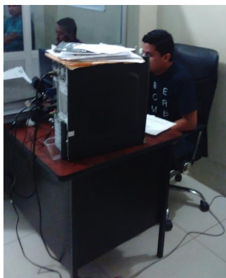
Figura 32: Riesgo eléctrico. Fuente:[Fotografía de Darío Guzmán y Xavier Chicaiza]. (2016). GAD Municipal del cantón Urdaneta. Urdaneta, Los Ríos.
