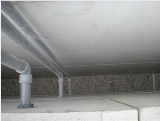
**Figura 45. Detalle Cámara de Lixiviados – Prefabricados de Hormigón**
