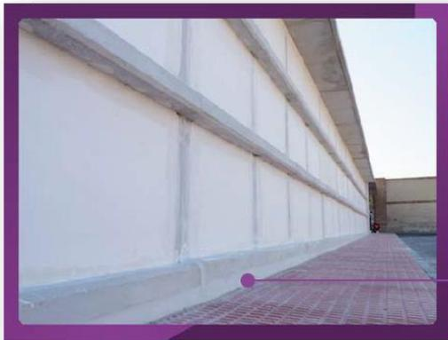
Murete de hormigón construido con bloques
