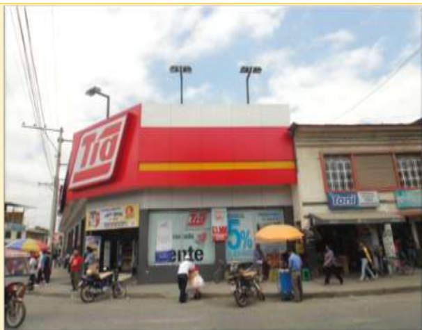
Foto 65.- Vista de Almacén Tía
