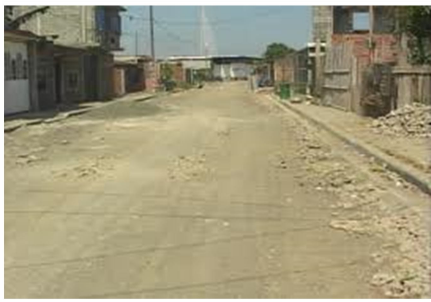
Figura N° 1.- Este sector que no tiene asfalto existe mucho polvo.
