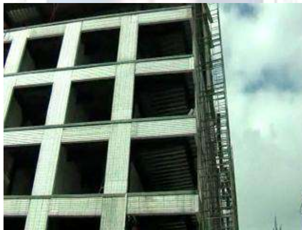
Armado de paredes (Panelería en Hormi2)
