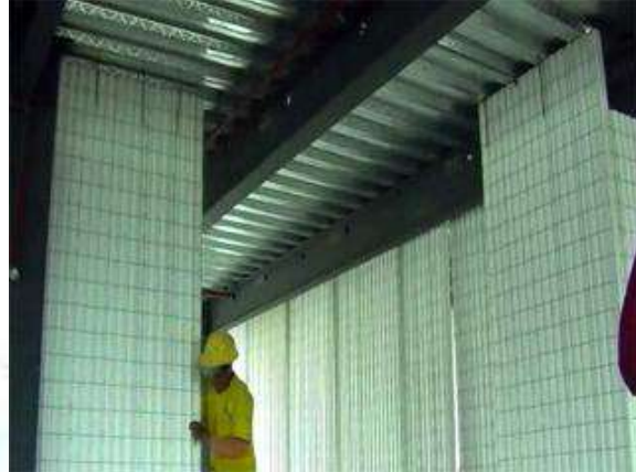
Colocación de paneles
