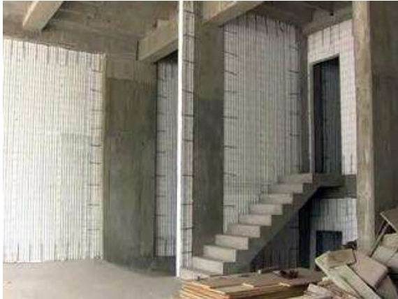
Armado de paredes
