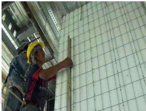
Aplome de paredes
