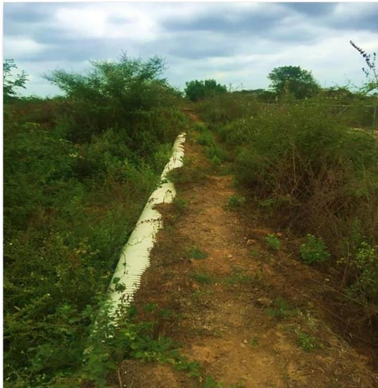
**Imagen N° 23:** Tubería expuesta a la superficie (Autor).
