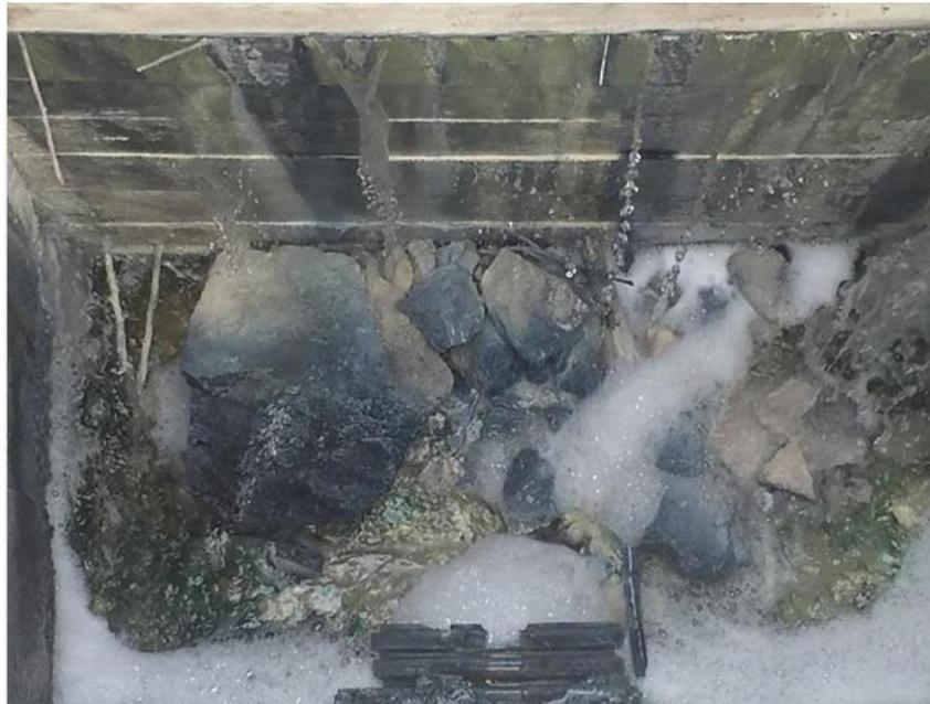
**Imagen N° 30:** Compuertas de rebose con filtración entre los tablonces (Autor).
