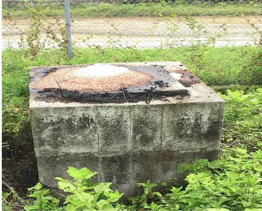
**Imagen N° 28:** Caja de registro obstruída y emanando espuma (Autor).
