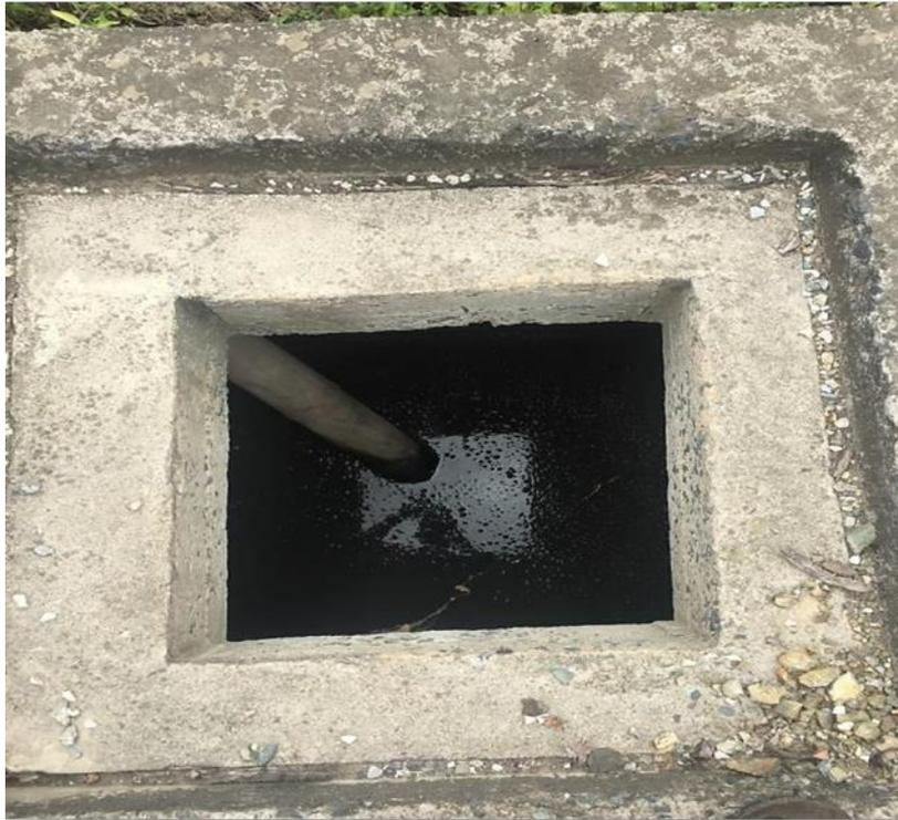
**Imagen N° 27:** Cajas de registro se encuentran obstruidas por materiales de construcción (Autor).
