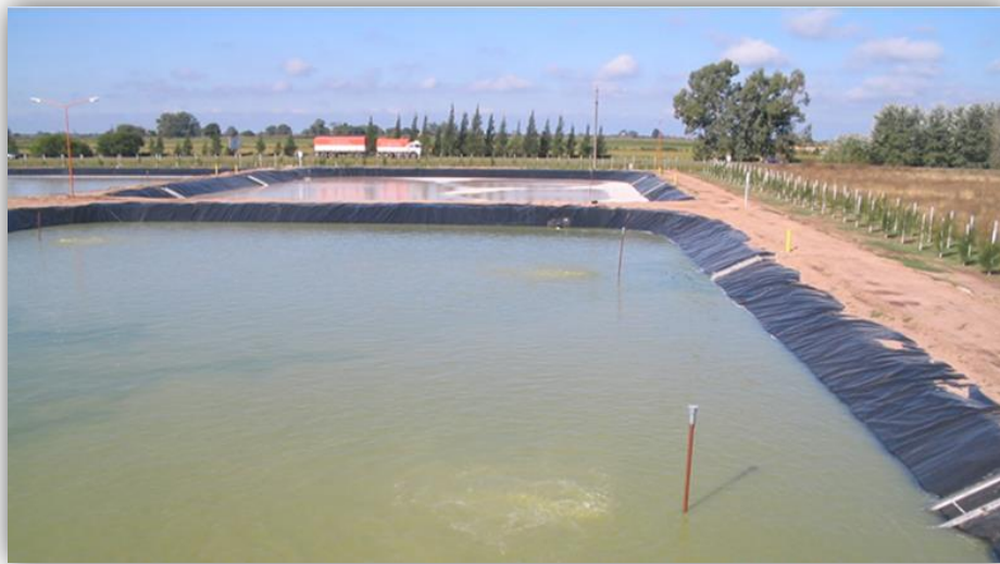
Foto Laguna de oxidación
