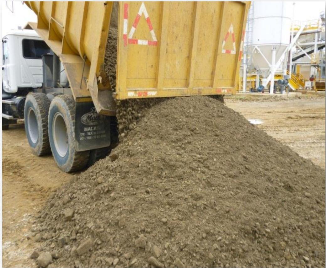
**FIGURA 3.4.1 Muestra de los agregados Finos y Gruesos que componen el material Base clase 1 tipo A.**
