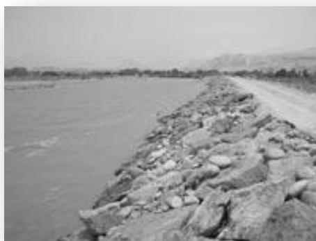
Imagen 46: Muro de enrocado
