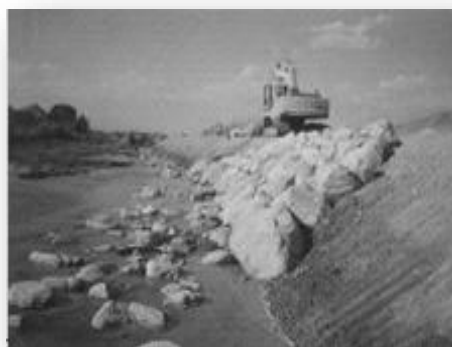
Imagen 45: Muro de enrocado
