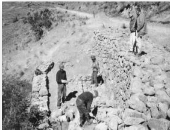
Imagen 44: Muro de mampostería
