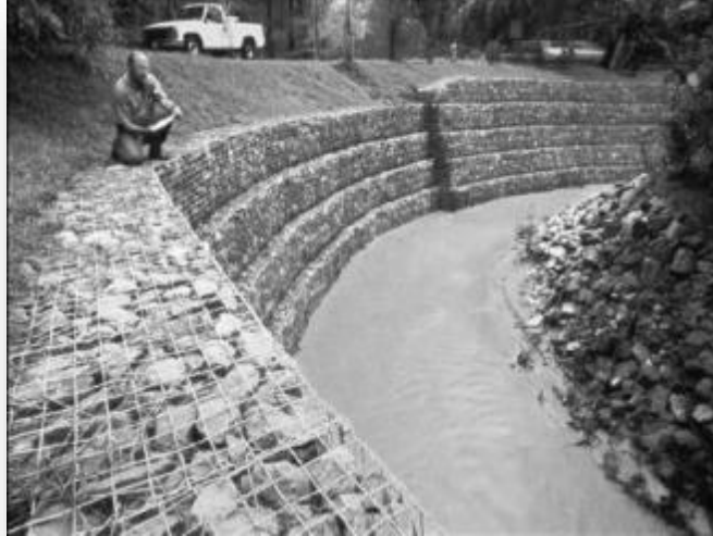
Figura 43: Muro de gaviones
