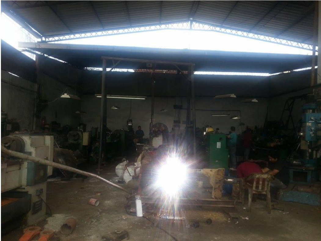
Planta de la Empresa Metal Mecánica Espín
