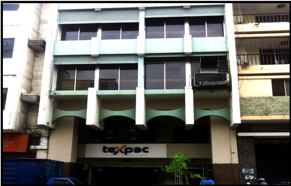
Fachada principal del Edificio donde funcionan las oficinas de la Empresa U.G.S.A.
