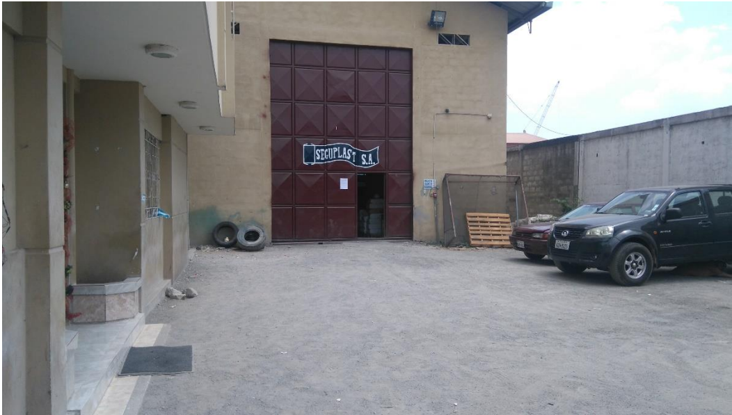
Anexo 5. Instalaciones de la empresa SEGUPLAST S.A.
